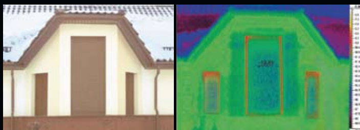
Рис. 2. Роллеты в закрытом положении
