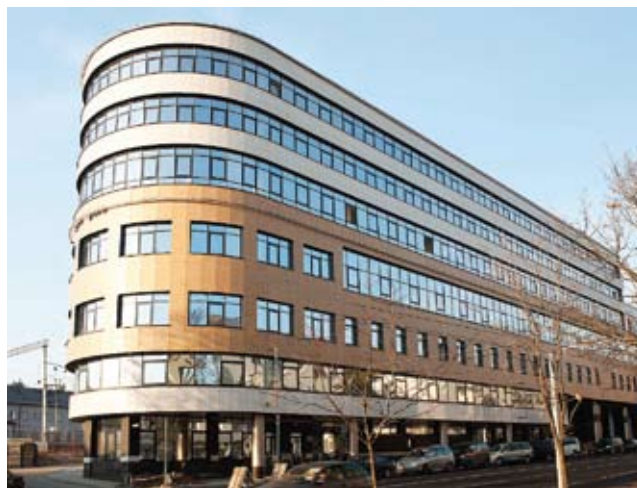
При строительстве здания автовокзала «Центральный» (г. Минск) использовалась система ALT F50
