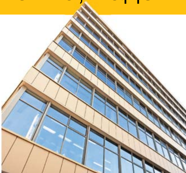
Фасад здания УП «Белпромпроект» (г. Минск) построен на основе системы ALT W72
