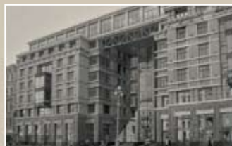
Жилой дом со встроенными помещениями. Невский пр., 133-137
