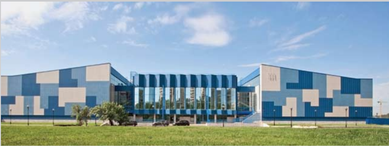
Реконструкция здания СДЮ-ШОР по футболу «Смена». СПб, Калининский район, ул. Верности, 21, литер А.
