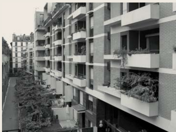
Париж. Жилищное строительство 1990х годов. Фото автора
