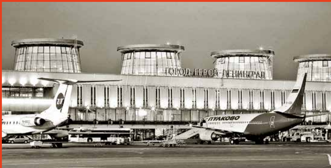
Аэропорт Пулково. 1973. Арх. А. В. Жук, Ж. М. Вержбицкий, Г. М. Вланин
