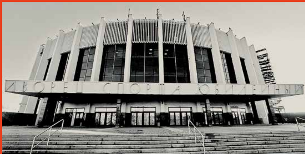
Дворец спорта «Юбилейный». 1967. Арх. А. П. Морозов, И. П. Сусликов, А. Левханьян, Ф. Яковлев, инж. А. П. Морозов, Ю. А. Елисеев, О. А. Курбатов
